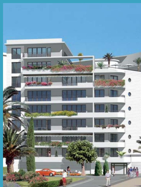
Arrière de la résidence - entrée parking
